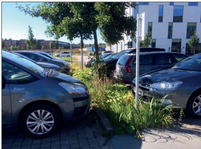
Parkeringsplads ved Kolding Åpark 1 hvor regnvandet håndteres i plantekummer.
