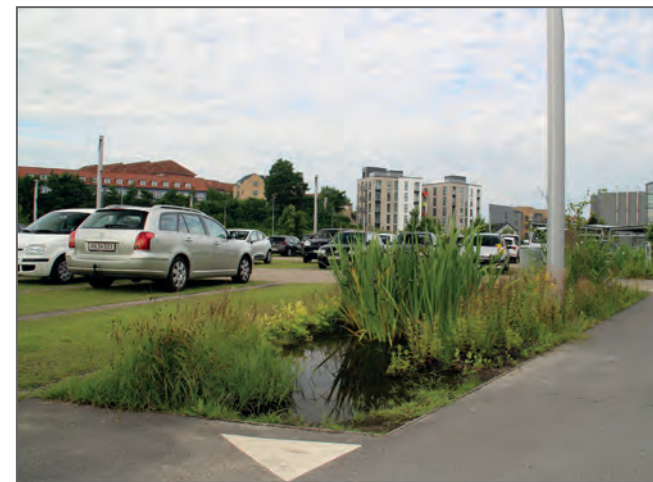
Parkering ved SDU på grus - midlertidig parkeringsplads med opstrikning i anden belægning og regnvandsbede.
