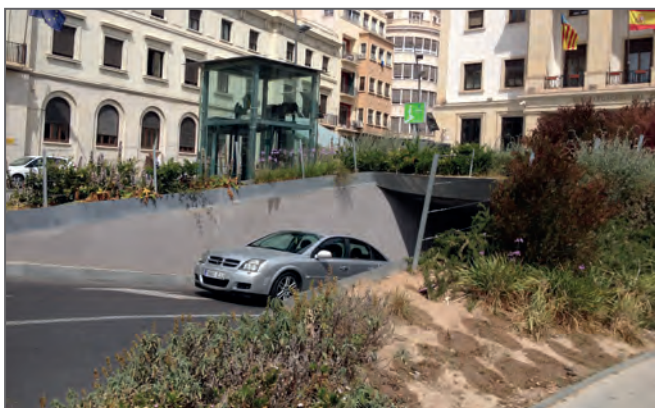
Nedkørsel til parkeringskælder omkranset af stort stau-debed - Alicante, Spanien.
